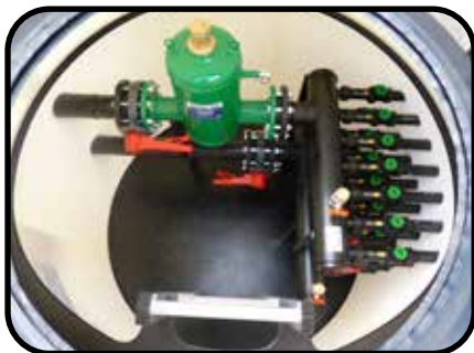
Verteilerschacht mit Mikroblasenabscheider
