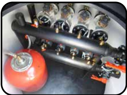
Übergeordneter Haupt-Verteilerschacht
