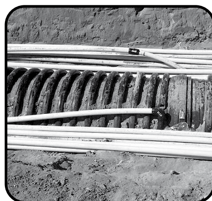
Einfacher Anschluss der Anbindeleitungen mit Heizwendelschweißmuffe
