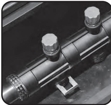
Verteilerschacht Typ WM mit Absperrventil
