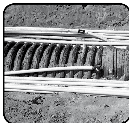
Einfacher Anschluss der Anbindeleitungen mit Heizwendschweißmuffe
